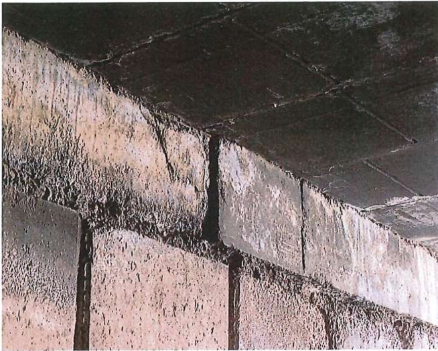
Նկ 4,5 Բետոնե բլոկերից իրականացված ափային հենարանները
