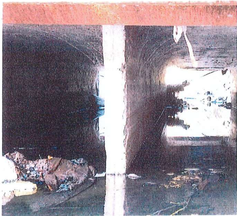
Նկ 5 Միաձույլ երկաթբետոնե միջնապատի բետոնի քայքայված տեսքը
