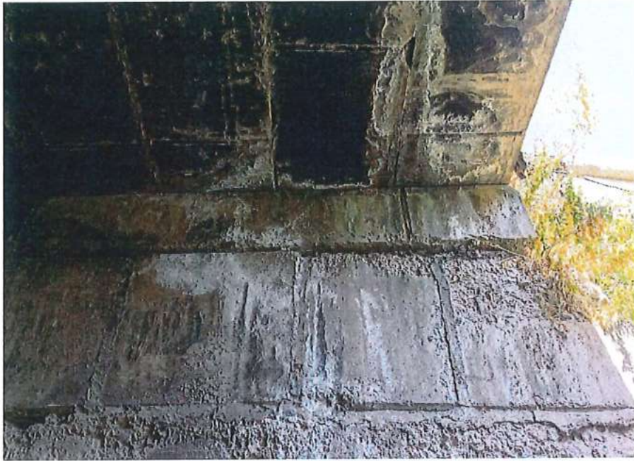
Նկ 16 Ափային հենարանների բետոնե բլոկերի անմխիթար վիճակը
