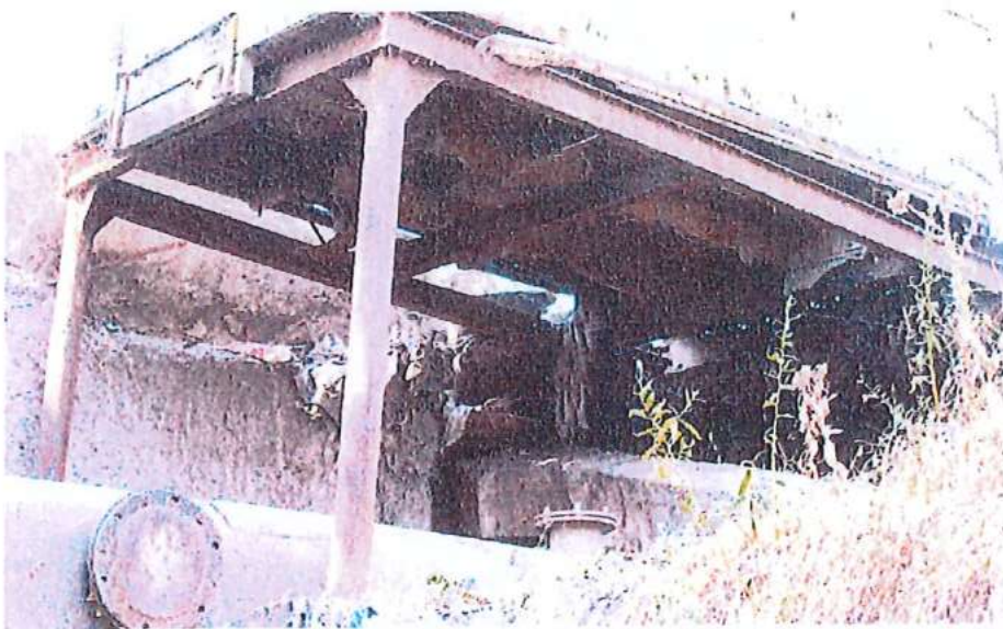
Նկ 9 Աջակողմյա ափային հենարանի ետնամասում փլուզված գրունտի տեսքը
